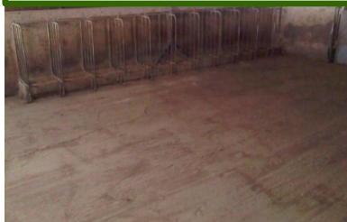
Suelo continuo compacto sin aberturas de drenaje
