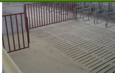
Suelo de hormigón emparrillado y sin emparrillar
