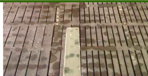
Dos tipos de emparrillado de hormigón: 160/20 y 80/20
